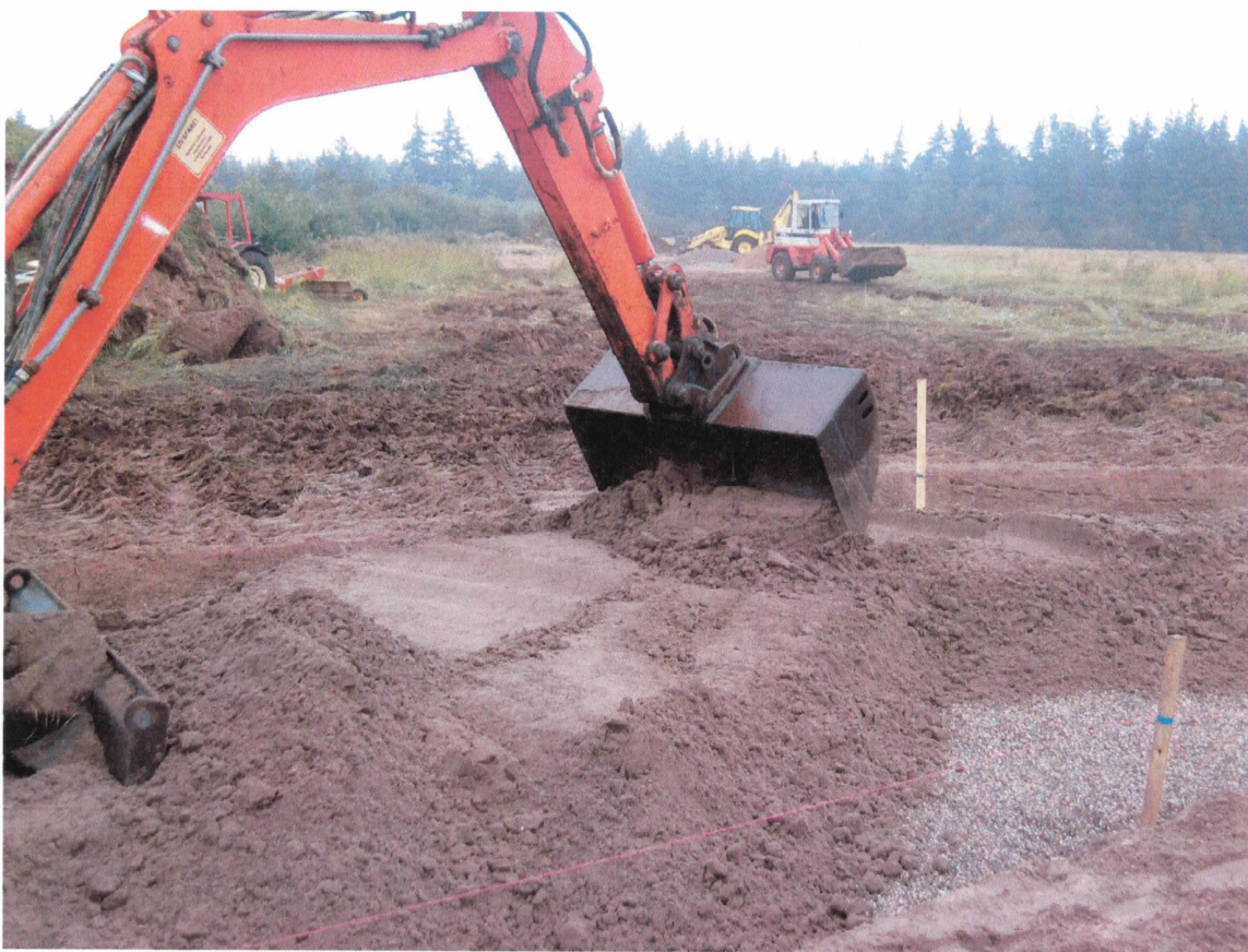
Udlægning af vækstlag.
